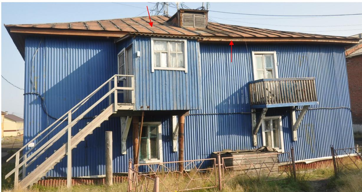
Фото 1. Прогибы бруса стен до 95 мм. Разрушение фальцевой кровли
