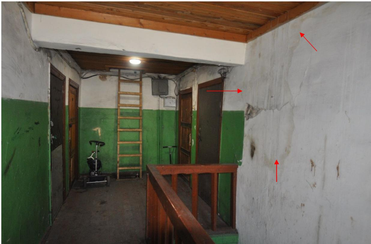
Фото 3. Замачивание стен – следы протечек кровли
