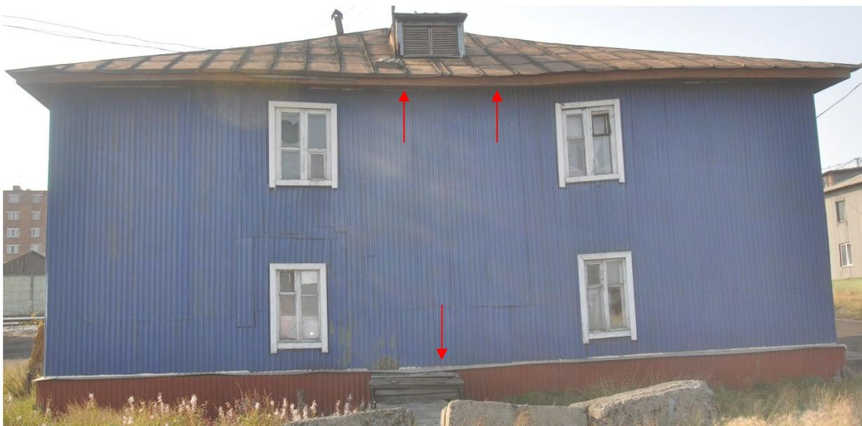
Фото 2. Прогибы бруса стен до 95 мм. Разрушение фальцевой кровли
