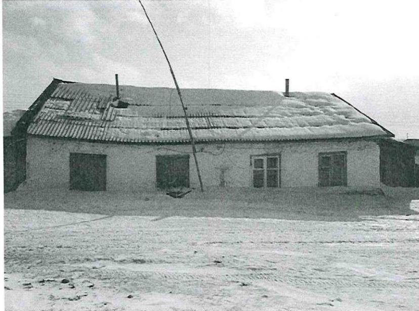
Неудовлетворительное состояние скатных крыш приводит к разрушению теплоизоляции чердачных помещений и нарушению температурно-влажностного режима, и как следствие, образованию наледи (сосуль) и увеличению снежного покрова. Во многих домах наблюдается разрушение несущих конструкций и подшивки деревянного перекрытия чердака. Из-за протечек кровли разрушается теплоизоляция и трубы печного отопления.
